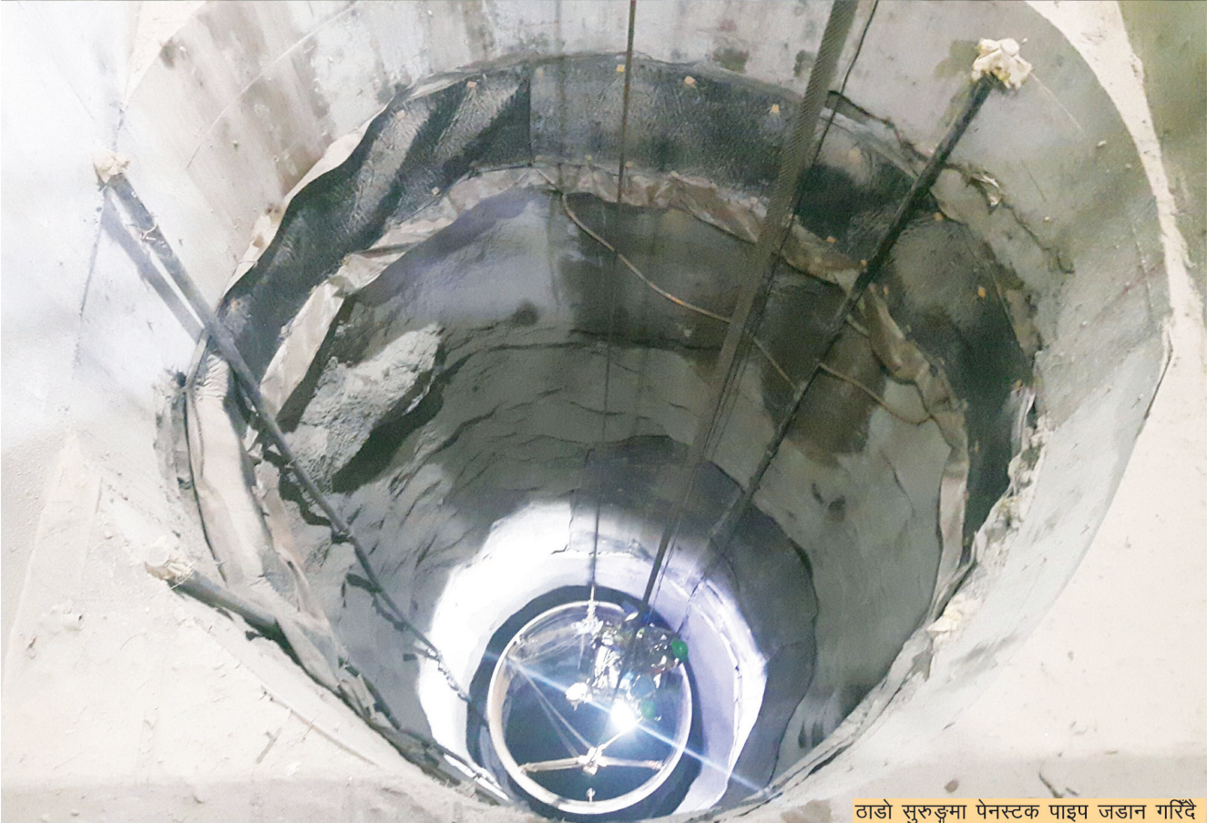
मुख्य सुरुङ्गमा कंक्रीट लाइनिङ्ग भईरहेको
